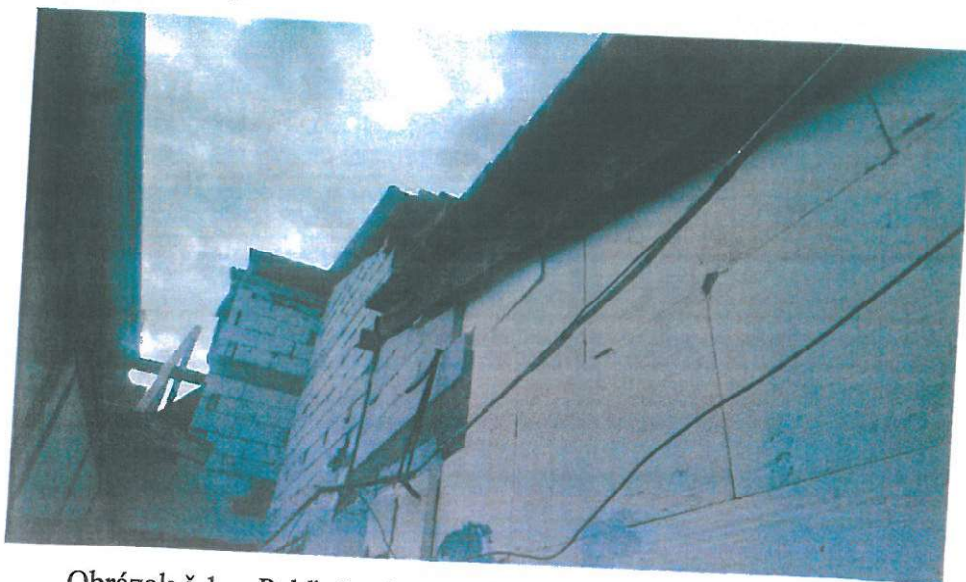
Obrázok č.1 Pohľad z dvora na konštrukčnú skladbu podkrovia
