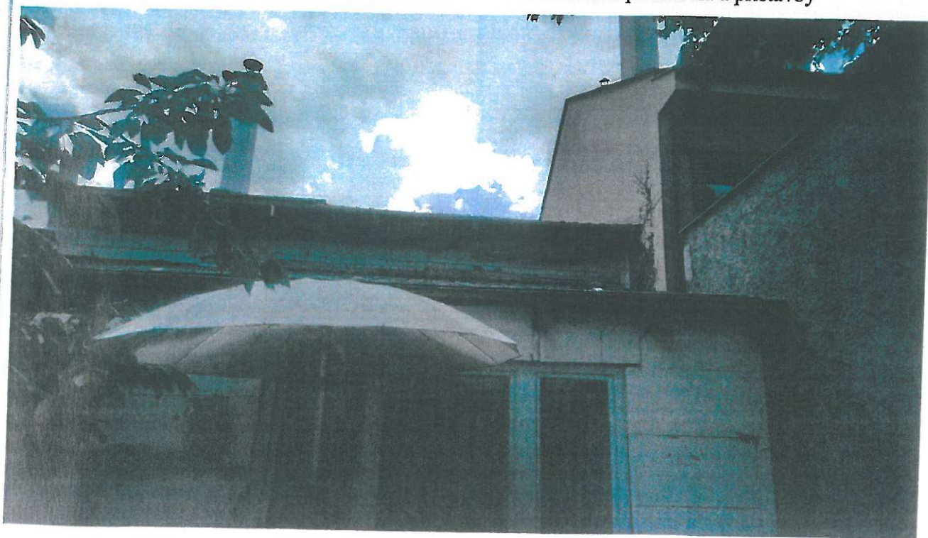
Obrázok č.3 Pohľad z dvora na konštrukčnú skladbu podkrovia a prístavby
