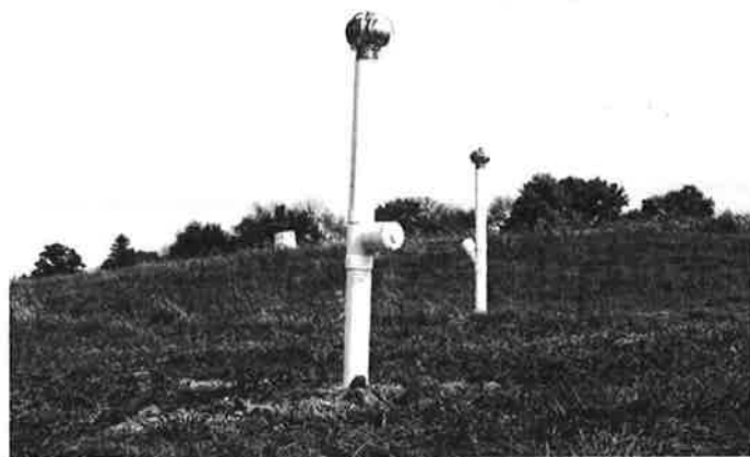
Obrázok 7: Vetrací komín s ventilačnou hlavickou na pasívne odvetrávanie – venting LFG do ovzdušia.
