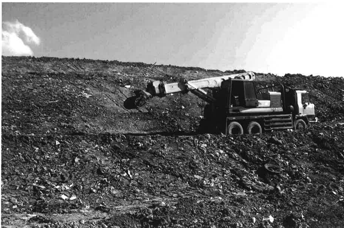
Obrázok 6: Úprava a odťaženie odpadu zo strmých svahov, založenie laviek a svahovanie telesa skládky do výsledného tvaru pred technickou rekultiváciou.
