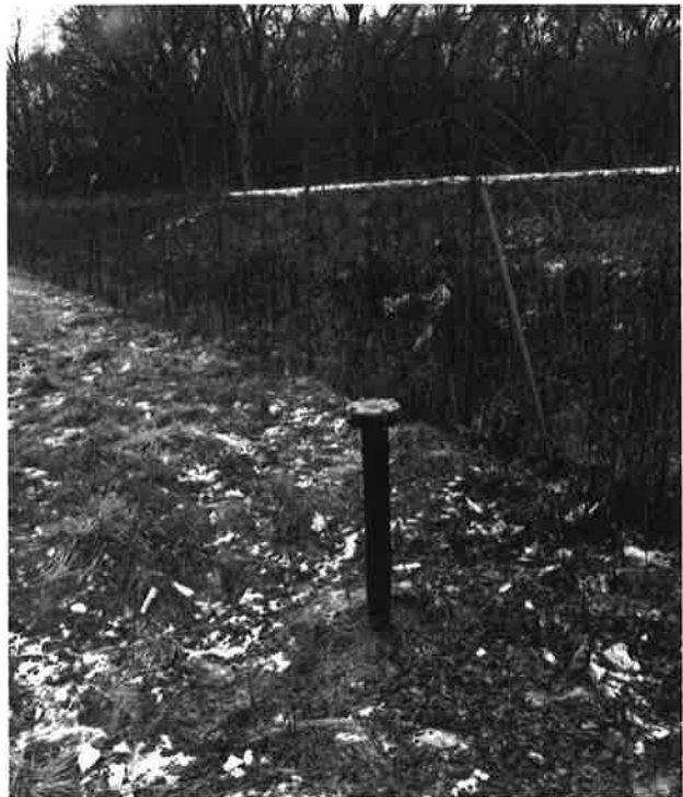
Obrázok 2: Preplachovací uzáver priesakovej drenáže
