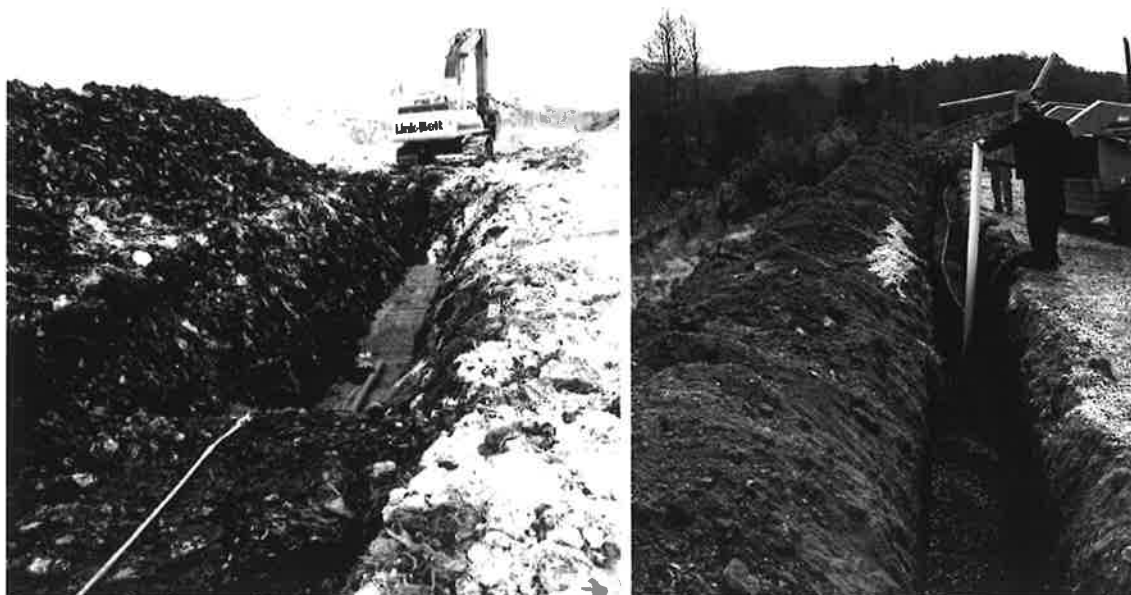
Obrázok 9: Postup budovania horizontálneho LFG drénu na strope odpadu
