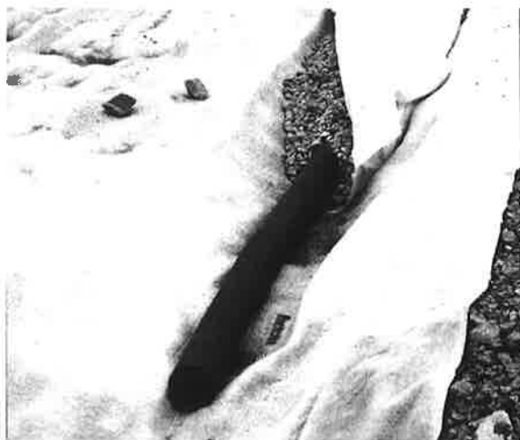
Obrázok 15: Spôsob odvodnenia zrážok na svahu skládky a flexidrén na lávke na odvádzanie vody z drenážnej vrstvy GDN.
