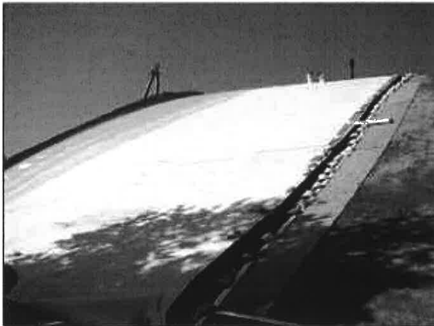
Obrázok 16: Pokládka syntetického geodrénu nad bentonitové tesnenie skládky (zdroj NAUE 2010)
