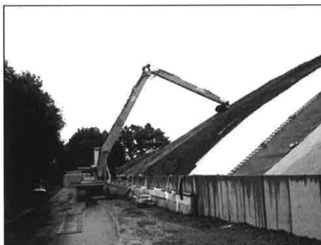
Obrázok 12: Úprava svahov skládky dlhým výložníkom a pokládka geosyntetických materiálov
