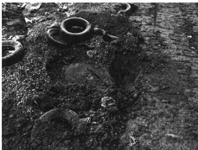
Obrázok 5: Ručný sondovací odkop pre určenie kotviaceho zákopu
