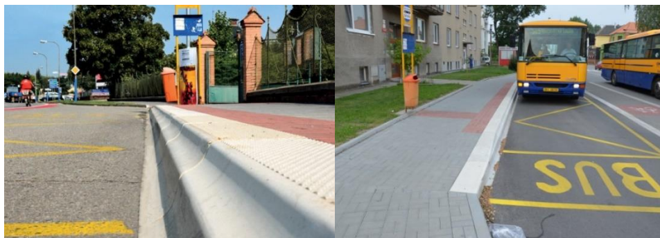
Obr.2.6.5 Bezbariérové zastávky MHD - detail Kasselský obrubník; Zdroj: 16
