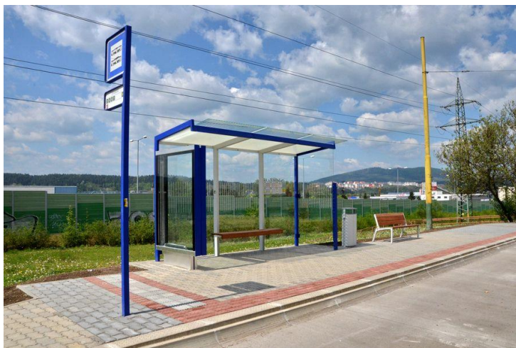
Obr. 2.6.6 Príklad novorekonštruovanej zastávky MHD v Žiline s aplikáciou debarierizačných opatrení a príslušnej výbavy; Zdroj: dpmz.sk
